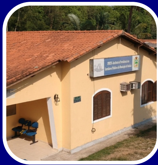
ATUAL SEDE ADMINISTRATIVA
